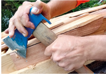
Holzschindel: in der hauseigenen Produktionsstätte in Oberwang gefertigt
