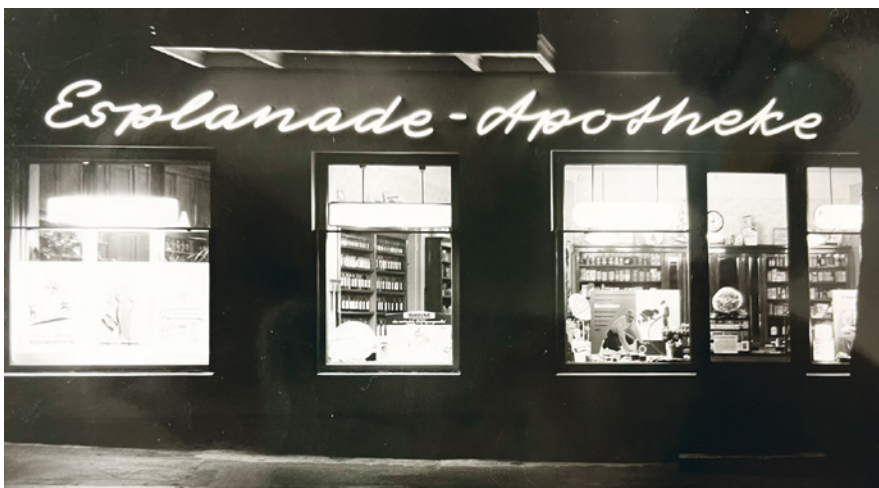
Die Esplanade-Apotheke nach dem Umbau 1960.
